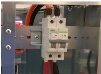
Figura 26 – Quadro elettrico RA.Store-3Bplus: interruttore di ON/OFF
